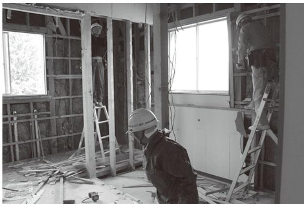
工事が始まった元気一番館
